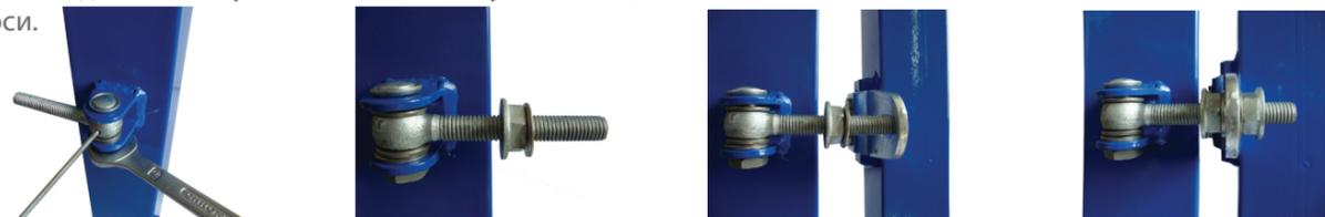
С помощью гаек произведите регулировку створки (створок), После регулировки можно приступать к установке антивандальных накладок петель.
